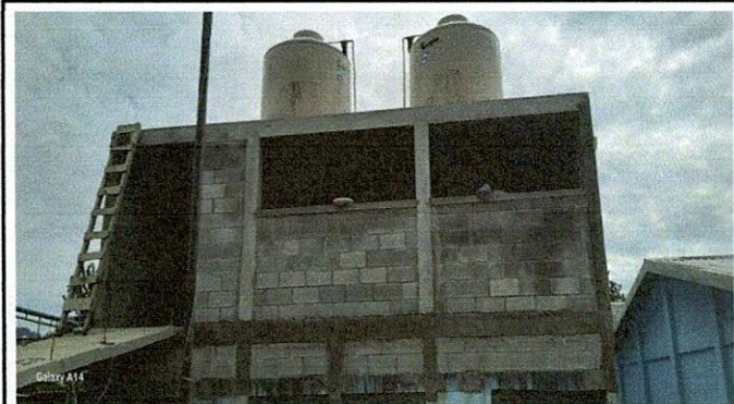
Foto 1: Mejoramiento de módulo de Baños, Drenaje y Fosa Séptica.
