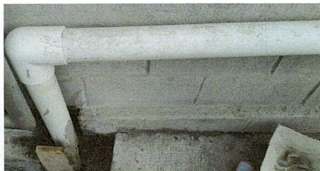
Foto 2: Mejoramiento de módulo de Baños, Drenaje y Fosa Séptica.
