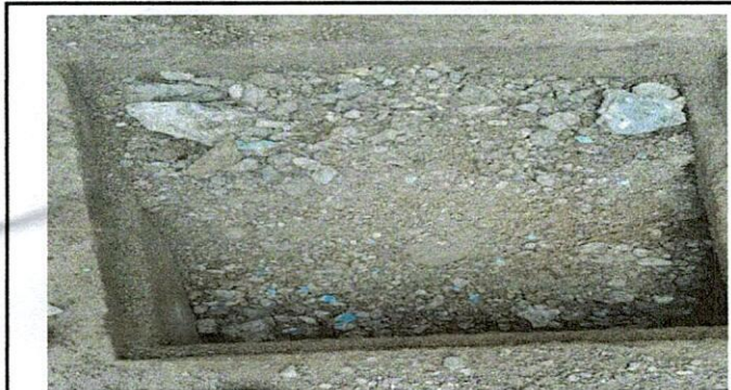
Foto 5: Mejoramiento de módulo de Baños, Drenaje y Fosa Séptica.
