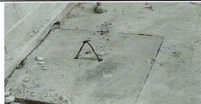
Foto 4: Mejoramiento de módulo de Baños, Drenaje y Fosa Séptica.
